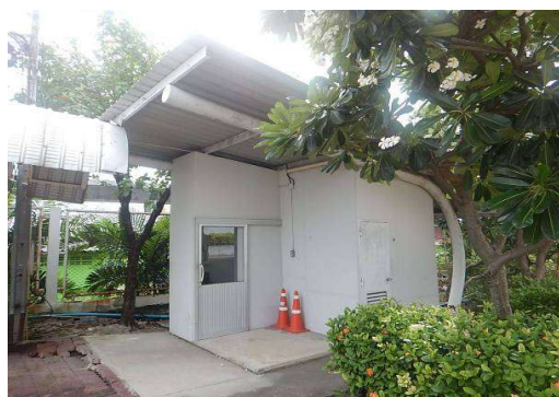
รายการที่ 5 อาคารควบคุมไฟฟ้าย่อย
