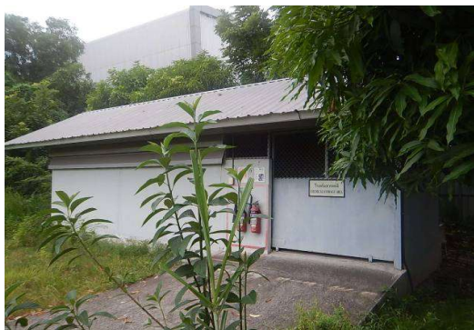
รายการที่ 4 โรงเก็บสารเคมี
