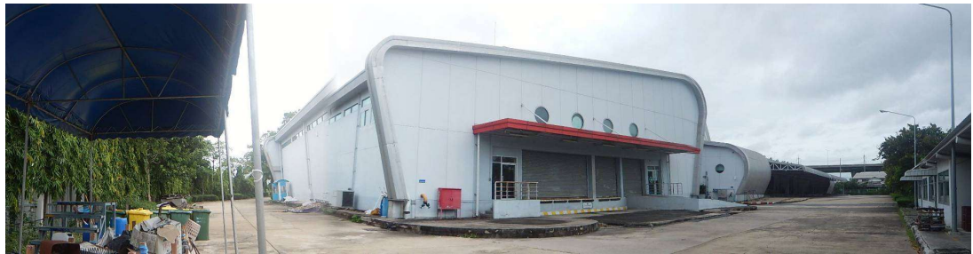
รายการที่ 2 อาคารคลังเก็บกระดาษพร้อมสำนักงาน
