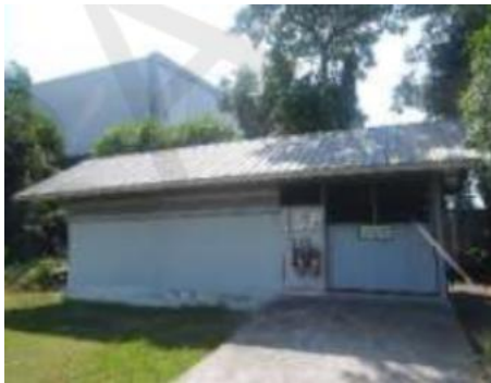
โรงเก็บสารเคมี
