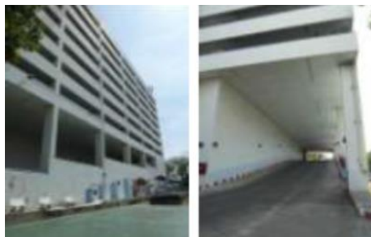
อาคารจอดรถ
