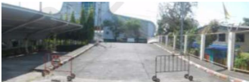
สะพานคอนกรีตเสริมเหล็ก (ข้ามคลองโองแตก)
