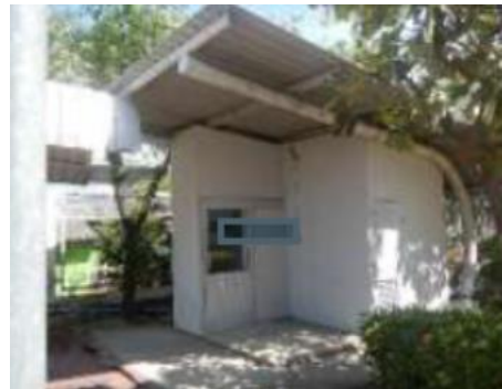
อาคารควบคุมไฟฟ้าย่อย
